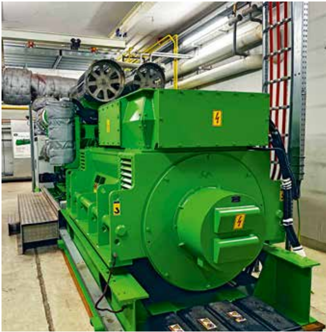
Das Blockheizkraftwerk der Georg Utz GmbH: Es könnte heute schon mit 20 % Wasserstoff betrieben werden.
