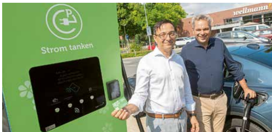
Musterbeispiel für die GEIG-Umsetzung: OPG-Geschäftsführer Wigand Maethner (links) und Blankenburg-Geschäftsführer Johannes Külens (rechts) an den OPG-Schnellladern am Einkaufszentrum Blankenburg in Osnabrück-Hellern
