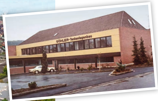
Das Firmengebäude in den 1980er Jahren in Hösbach.
