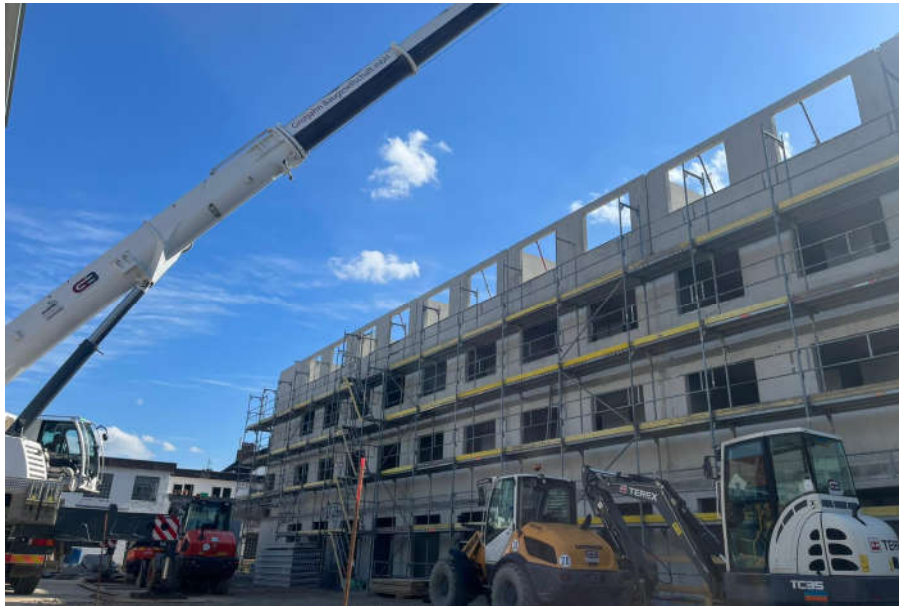
Fertig ist der Rohbau The building shell is finished
