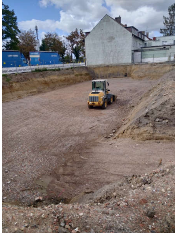
Baufläche vorbereiten Prepare construction site
