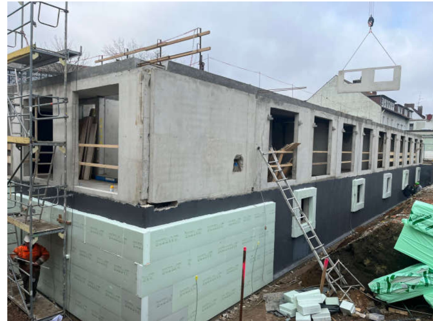
Abdichten und Dämmen Sealing and insulating
