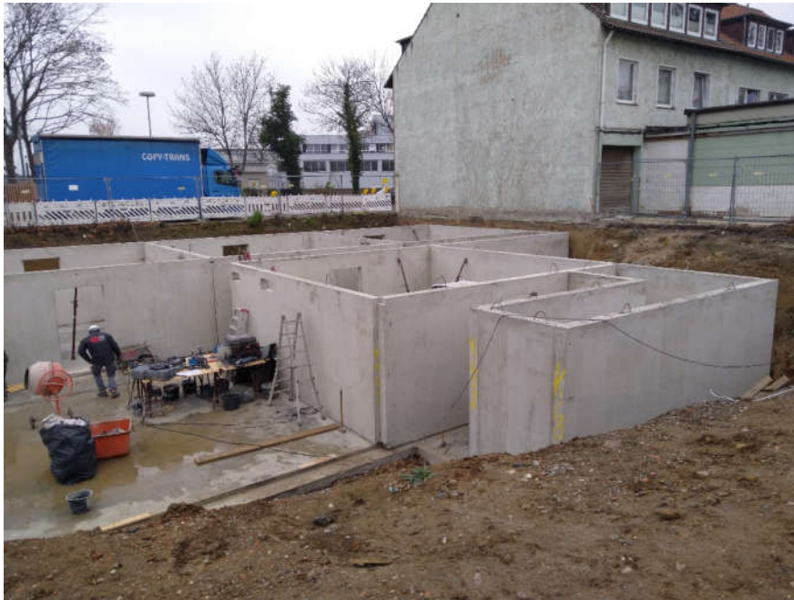
Wände aufstellen Erect walls
