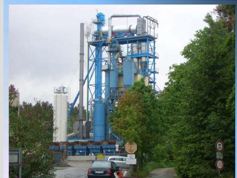
**Asphaltmischanlage mit Paralleltrommel**
