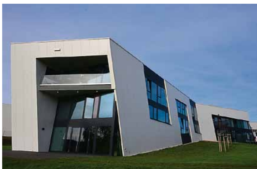
Das Firmengebäude von IMK Engineering in Chemnitz. Fotos: IHK / W. Schmidt
