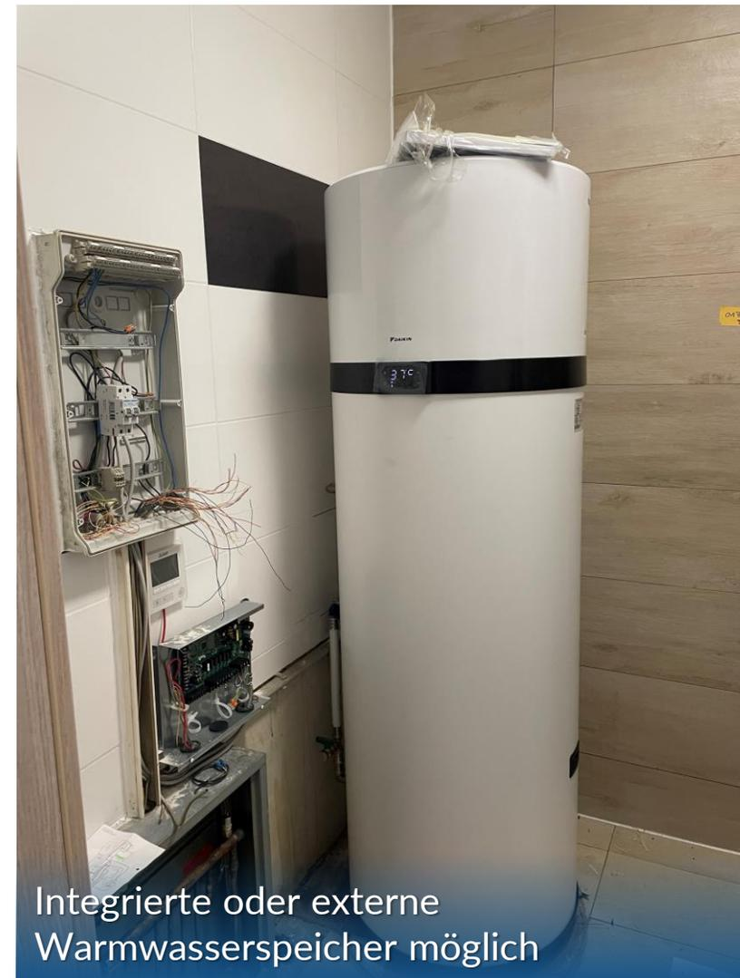
Integrierte oder externe Warmwasserspeicher möglich
