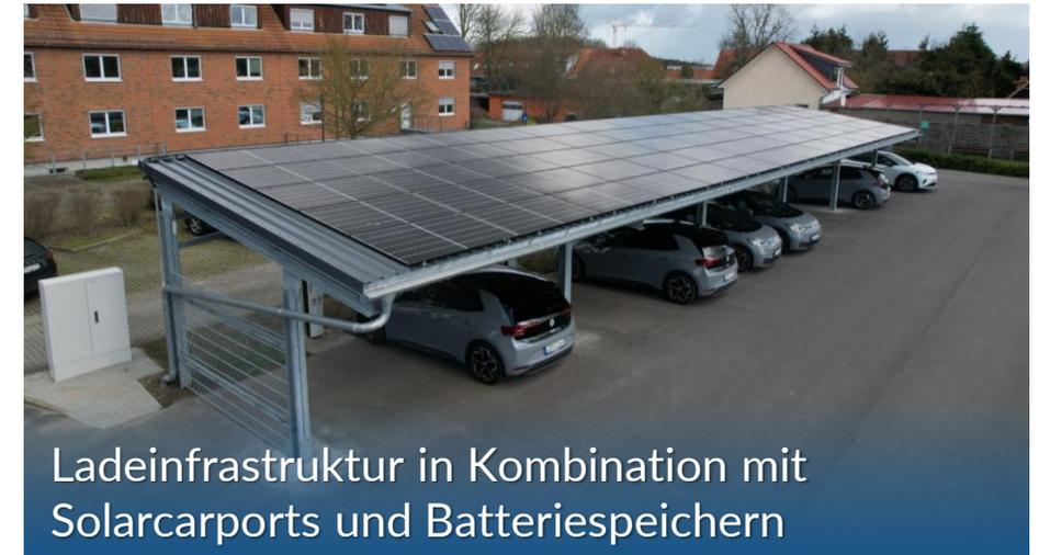
Ladeinfrastruktur in Kombination mit Solarcarports und Batteriespeichern
