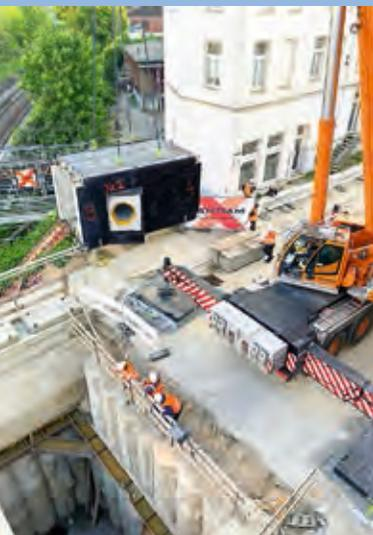
▲ In zehn Metern Tiefe wurde der aus vier Segmenten bestehende Medientunnel zusammengefügt.
