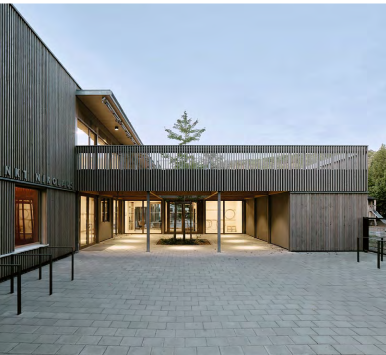
Das Familienzentrum St. Nikolaus in Gau-Algesheim verbindet Funktionalität und Ästhetik mit einer ressourcenschonenden Bauweise. Foto: Lennart Wiedemuth
