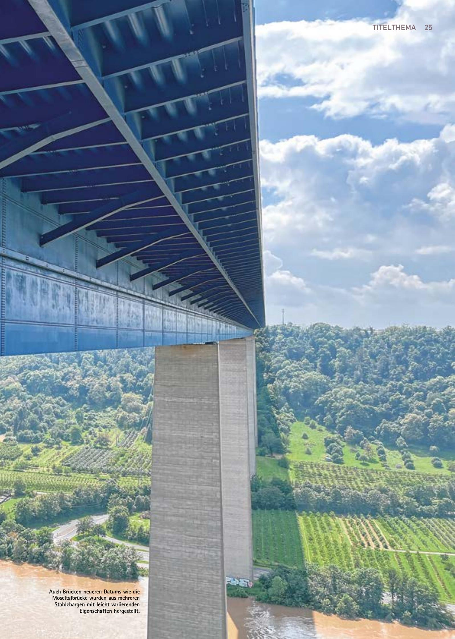
Auch Brücken neueren Datums wie die Moseltalbrücke wurden aus mehreren Stahlchargen mit leicht variierenden Eigenschaften hergestellt.
