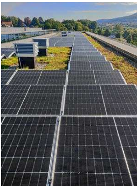
Auf dem Dach des IHK-Bildungszentrums wurde eine Photovoltaikanlage mit knapp 100 kW Leistung installiert. Foto: IHK
