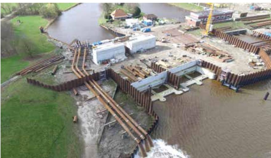
Der Wasserlauf wird über ein Lückmann-Pumpen- und Rohrsystem überbrückt.
