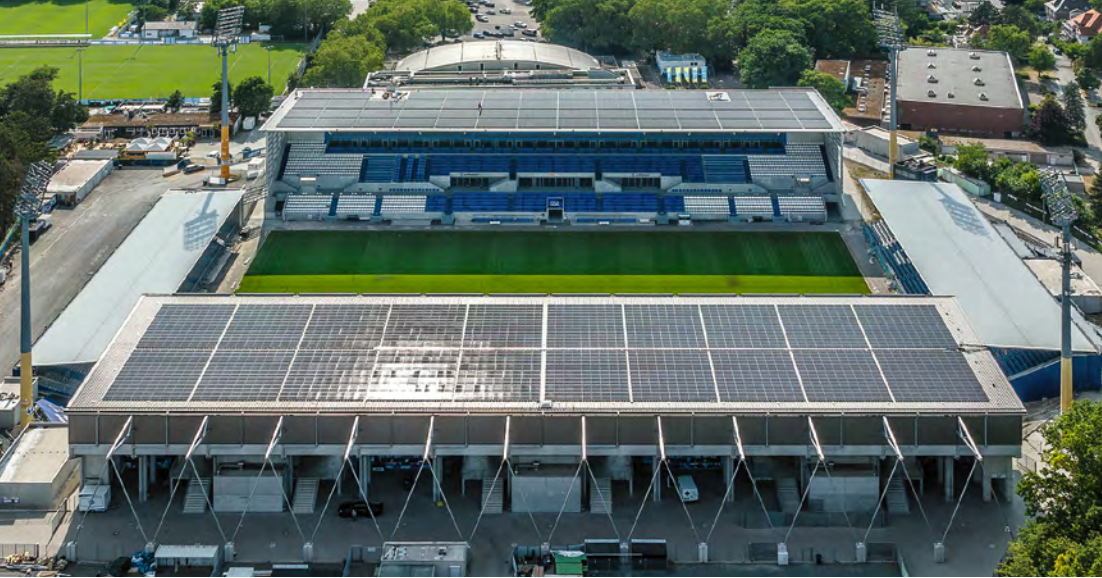
Solarmodule auf der Haupttribüne und der Gegengerade versorgen das »Bölle« mit Strom. Foto: Entega
