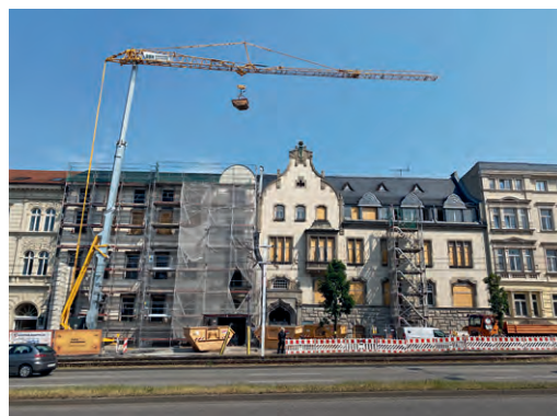
Blick auf das gerade im Bau befindliche Gebäude der IHK Halle-Dessau mit dem Eingangsportaal in der Franckestraße
