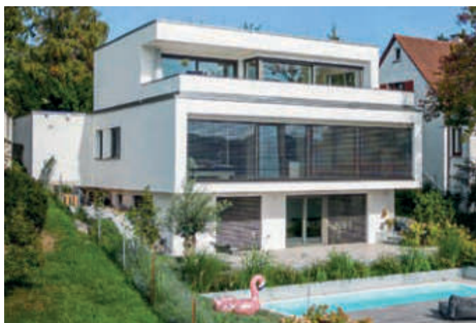
FERMO Kundenhäuser: individuell geplant und gebaut
