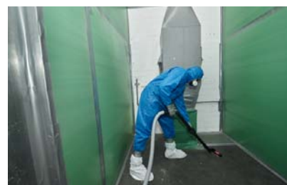
Reinigung des Arbeitsbereiches
