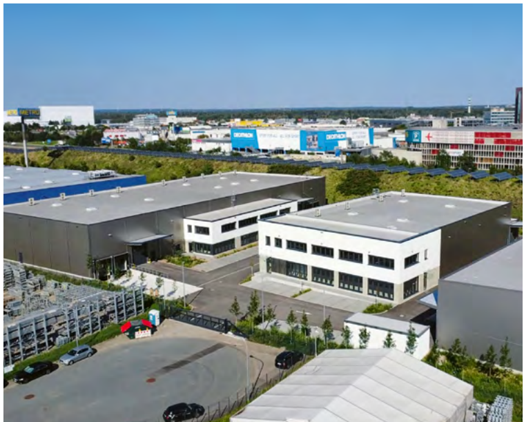
Im Westen der Shoppingmall Loop5 in Weiterstadt ist ein Gewerbepark entstanden. Foto: Four Parx GmbH
