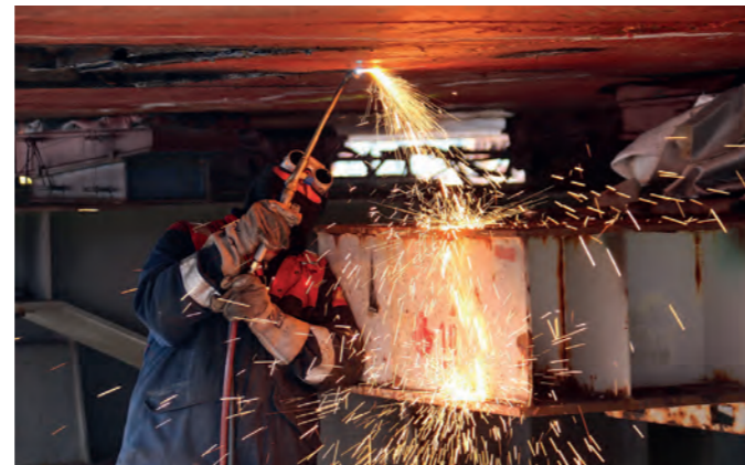
Zu den Schwerpunkten im Schiffsreparatursektor gehören Arbeiten im Stahlbereich.
