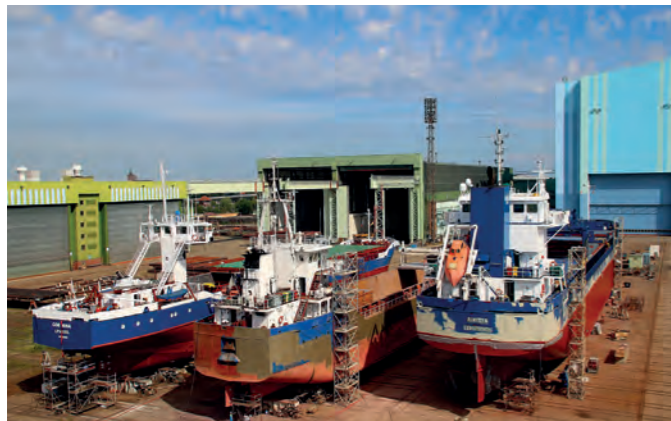
Der Schiffsliift und ein weites Verschiebegelände ermöglichen es, gleichzeitig mehrere Schiffe zu docken und daran zu arbeiten.
