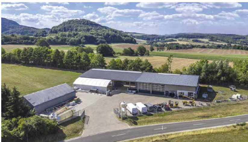
Blick auf das Firmengelände
