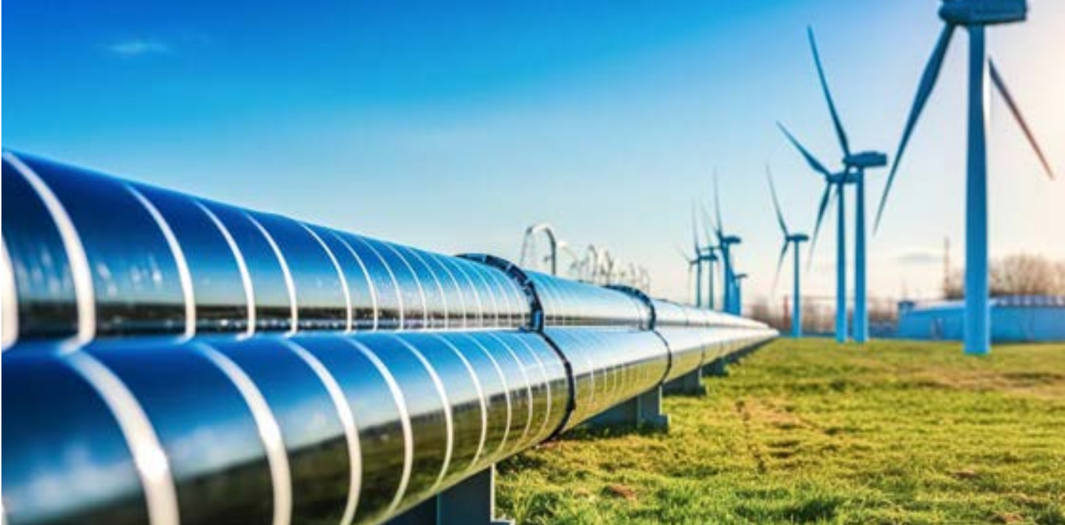
Per Pipeline soll Wasserstoff zu Großverbrauchern wie Kraftwerken und Industriebetrieben kommen. Foto: Adobe Stock / Vks_jin
