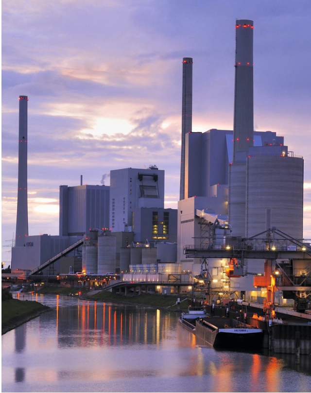
Das GKM in Mannheim ist zentral für die Energie- und Wärmeversorgung in der Region.
