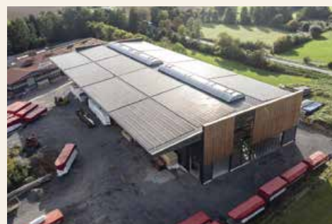
Neue 3D-Modulbauhalle zur Fertigung von Raummodulen in Weyhers (Foto: Christian Tech)
