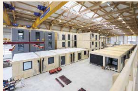
Raummodule in flexibler Holzmodulbauweise – komplett schlüsselfertig inkl. Fassadengestaltung (Foto: Christian Tech)
