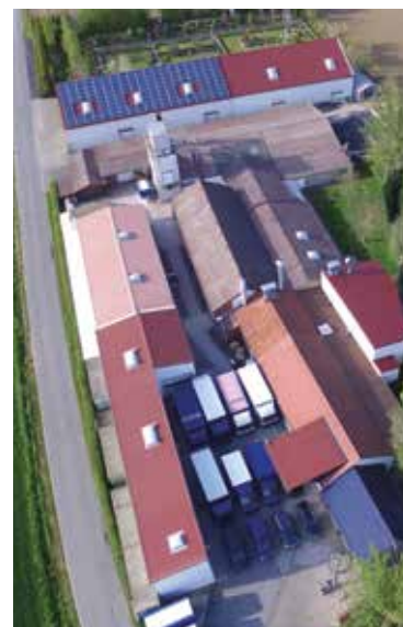
Blick auf den Firmensitz in Hamm.
