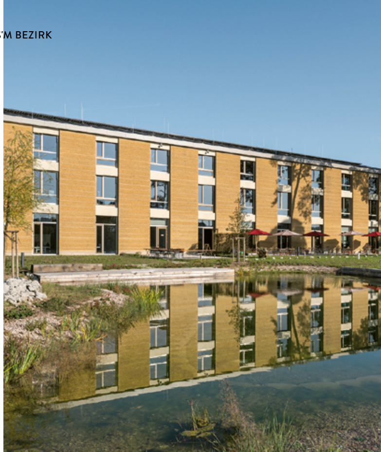
Die Alnatura-Zentrale nördlich der Eschollbrücker Straße in Darmstadt. Foto: Alnatura/Lars Gruber
