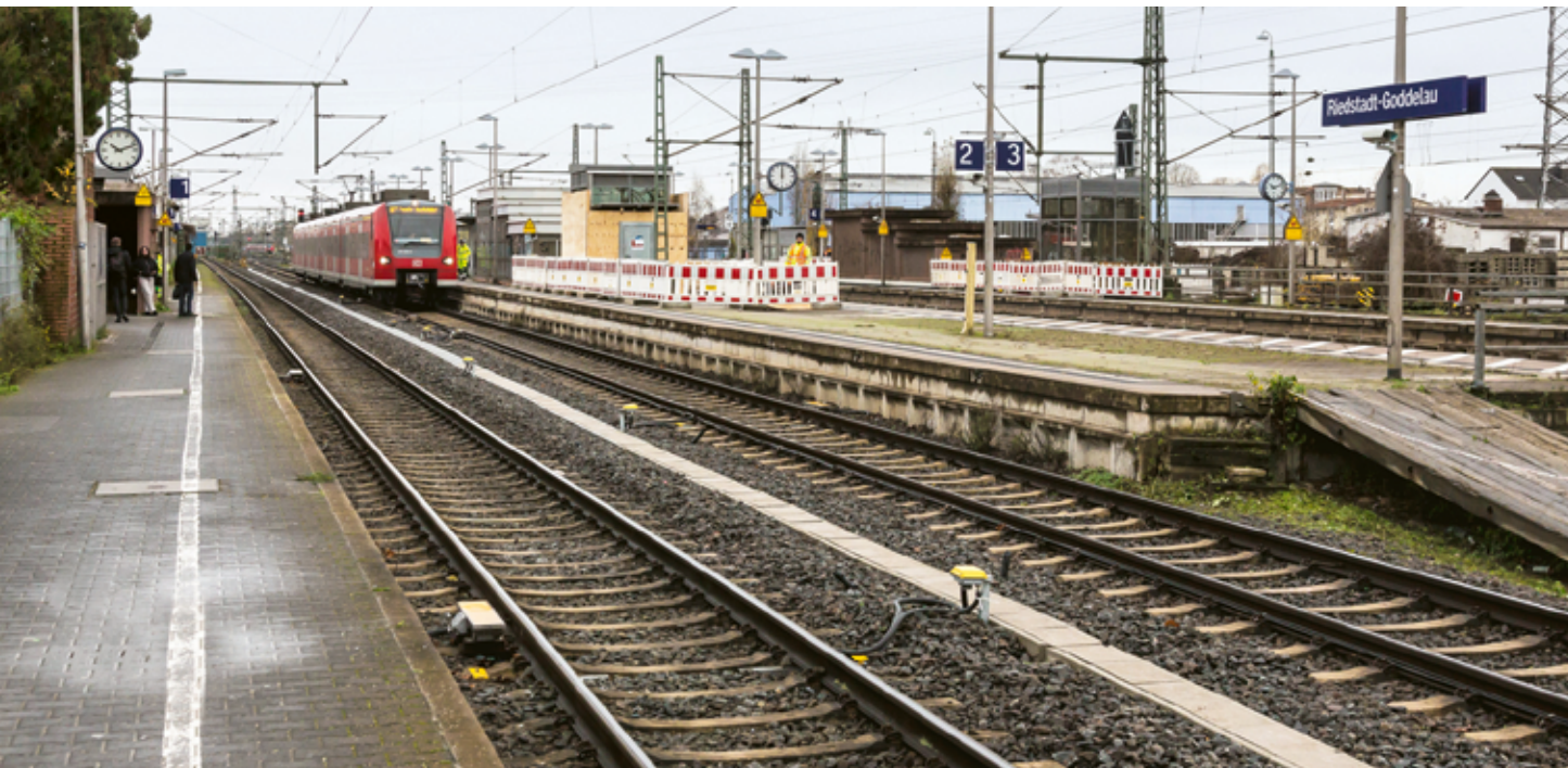
20 Bahnhöfe entlang der Riedbahn sollen modernisiert werden. So wird zum Beispiel in Riedstadt-Goddelau die Bahnsteighöhe angepasst und es werden neue Fahrradparkplätze geschaffen. Foto: Lothar Mantel
