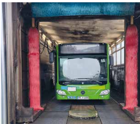
Spart bei 4600 Fahrzeugwäschen im Jahr rund 1900 Kubikmeter Frischwasser ein: Die Aufbereitungsanlage der RhönEnergie Fulda
