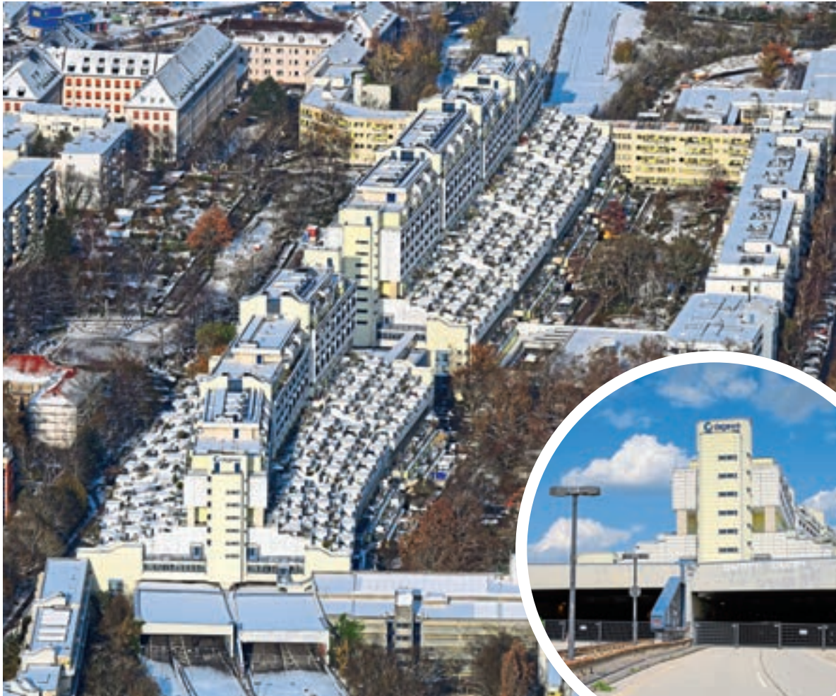
Einzigartig: der Wohnkomplex Schlangenbader Straße über dem seit fast einem Jahr gesperrten Tunnel
