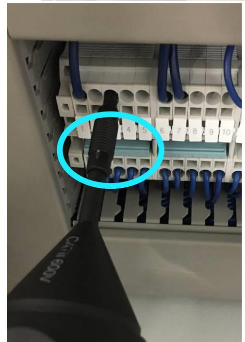
Führen Sie nun die Messung durch. Anschließend führen Sie dieselbe Messung an L2, L3 und N durch.
