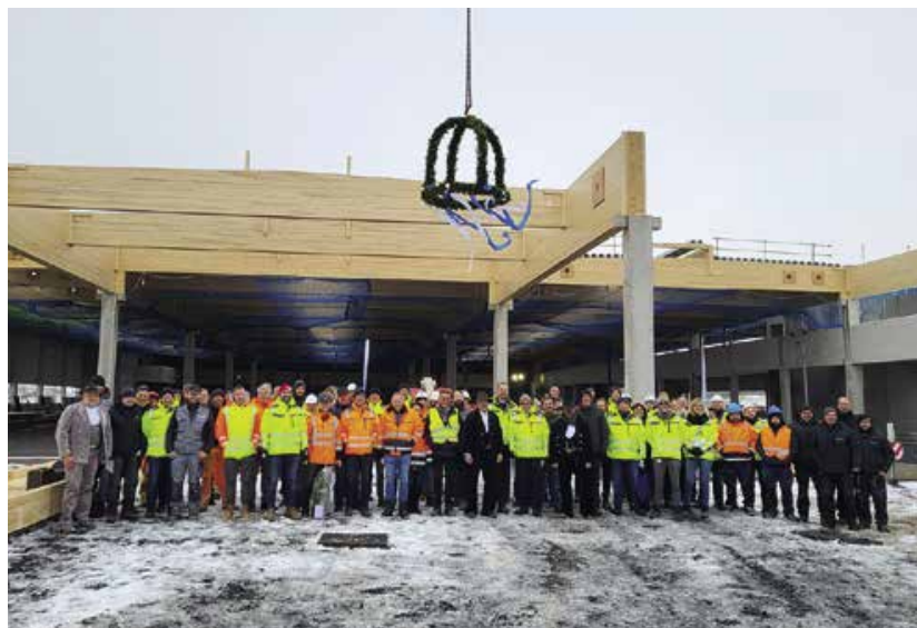
Durch gelungene Teamarbeit schreiten die Bauarbeiten am Jumo-Werk zügig voran
