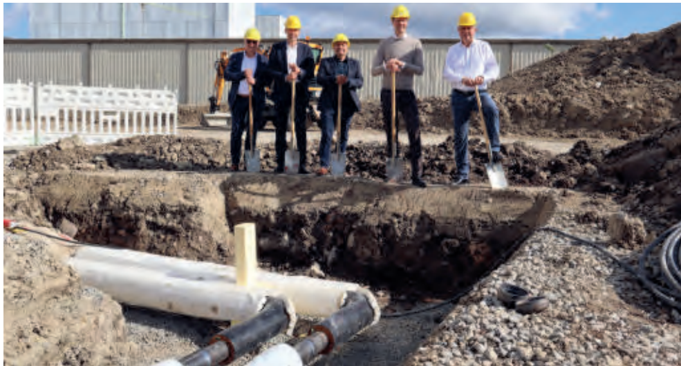
1200 METER LANG wird die Fernwärmeleitung, für die jetzt der Spatenstich erfolgte.
