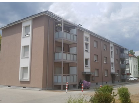
Vorher und nachher: Das Gebäude in der Eichendorffstraße wurde nach der Sanierung zum KfW-Effizienzhaus 70.
