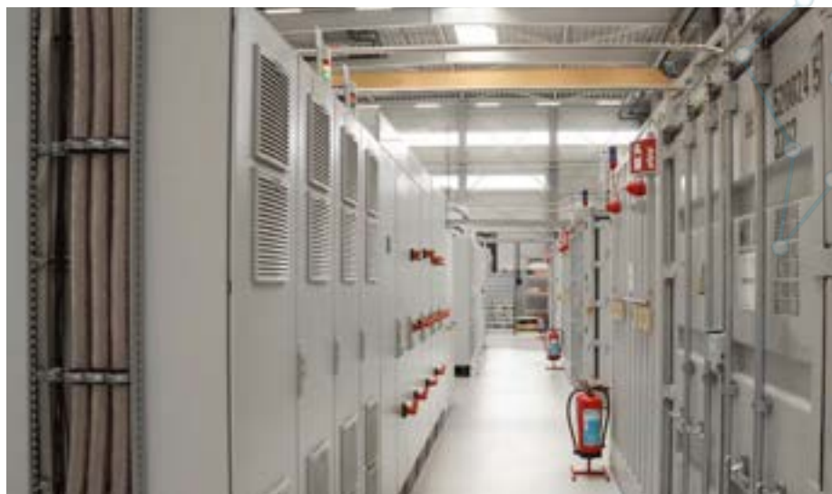
Batterieprüffeld in Remshalden.
