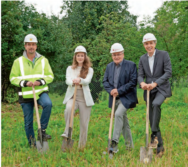
Der Spatenstich für den Neubau der Sparkasse in Rottenacker. Foto: Sparkasse Ulm
