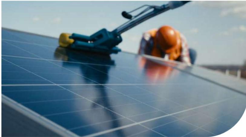
**Etwa alle zwei Jahre sollte eine Wartung der PV-Anlage durchgeführt werden. In diesem Zuge oder je nach Bedarf kann auch die Reinigung erfolgen.**
