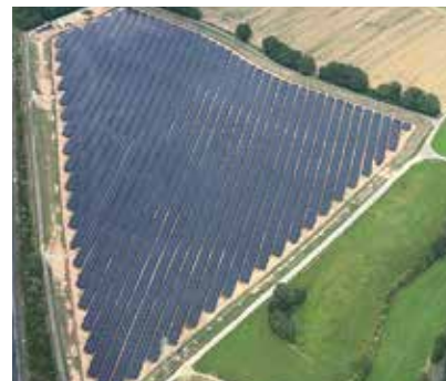
Der auf dem Feld gewonnene Sonnenstrom wird in das nahegelegene Umspannwerk in Welkers eingespeist
