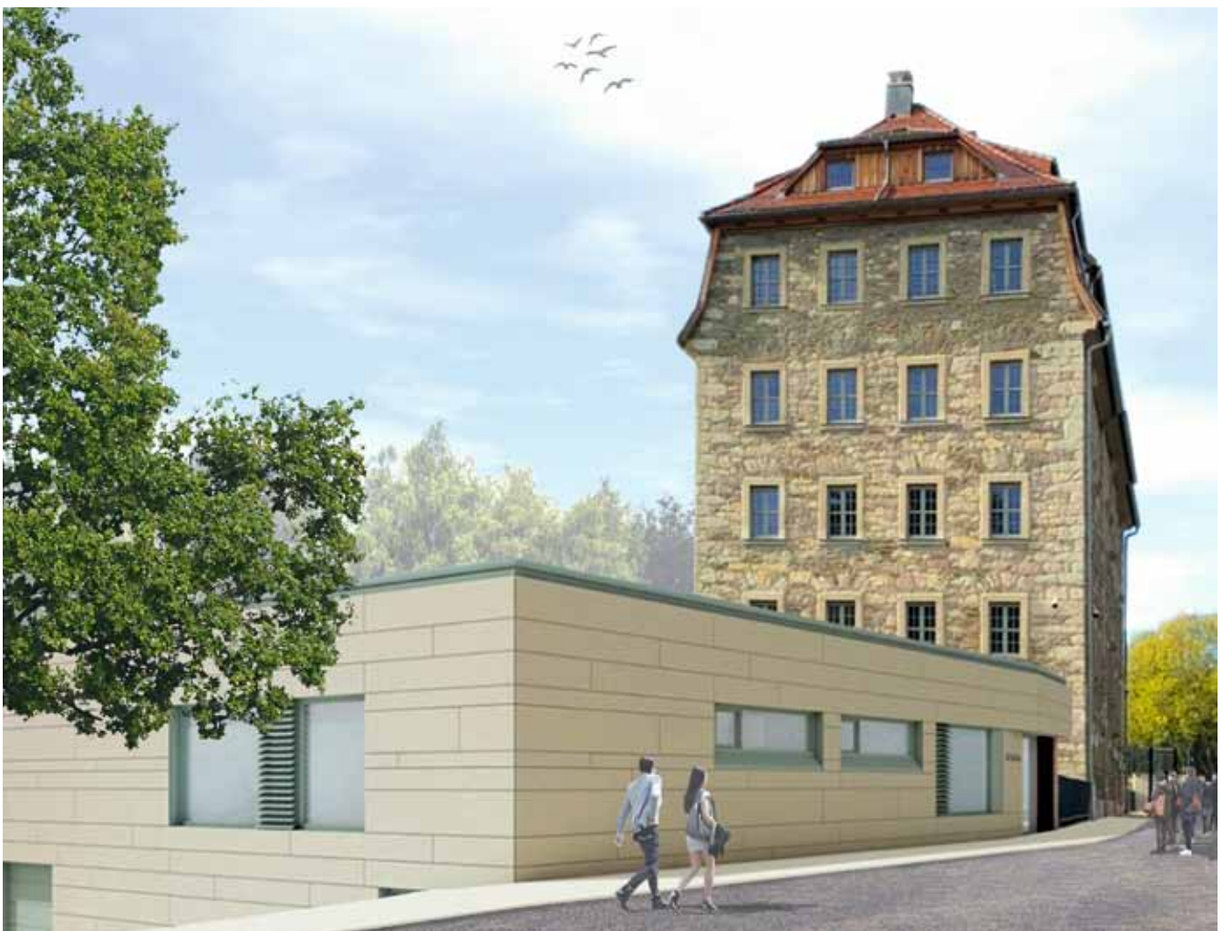
Die neue Produktionshalle von imk in Chemnitz-Altenhain.
