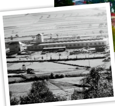
Das Fabrikgebäude in Amorbach im Gründungsjahr 1948.
