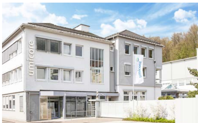
Das Verwaltungsgebäude Werk 1 in Schwäbisch Gmünd. Foto: Umicore
