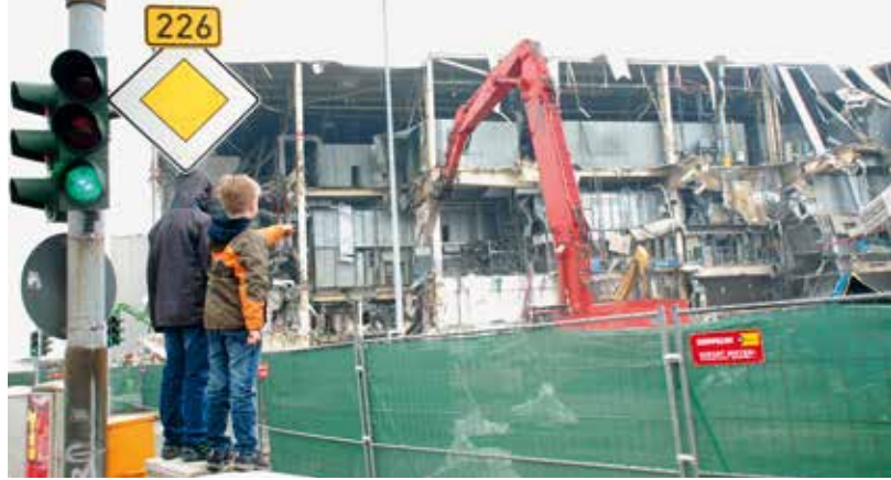
Abriss des ehemaligen Opel-Werks in Bochum: Bevor eine Fläche neu vermarktet werden kann, muss sie meist aufwendig saniert werden.
