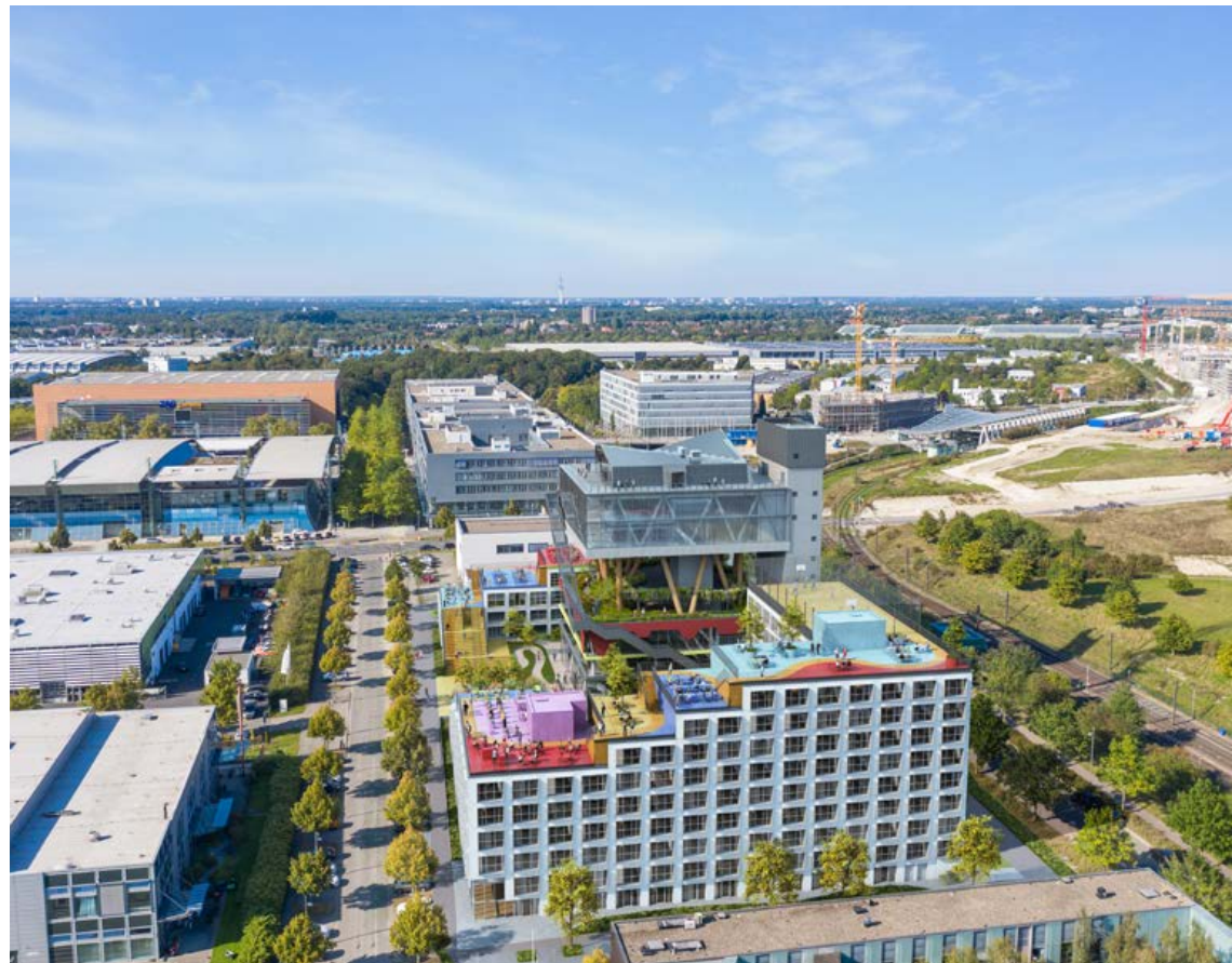
So soll das Projekt von iLive in Hannover auf dem ehemaligen EXPO-Gelände aussehen. Foto: iLive Group GmbH
