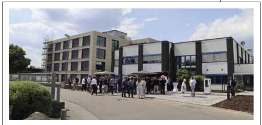
AMEFA hat ein neues viergeschossiges Bürogebäude im Dietkircher Gewerbegebiet neben dem bisherigen Verwaltungsgebäude gebaut.
