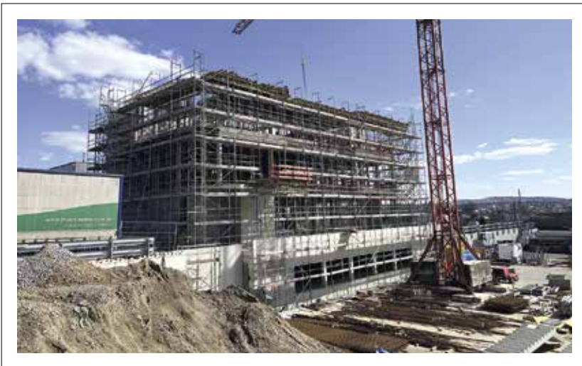
Der Rohbau für das neue Bürogebäude der MUCH-Gruppe ist fertiggestellt.
