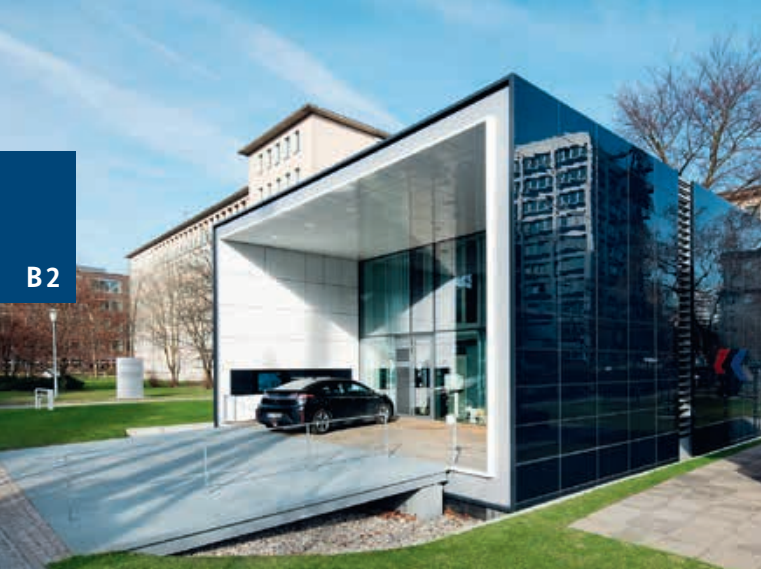
Pilotprojekt des Bundesbauministeriums zur Umsetzung der Effizienzhaus Plus-Anforderungen
