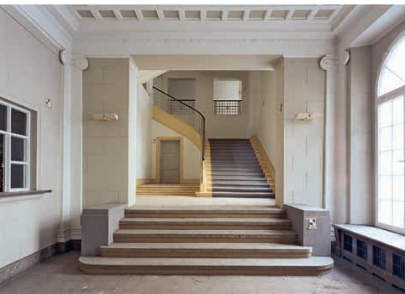
Vor dem Hintergrund der vielfältigen Nutzungsgeschichte wurde das Foyer des Altbaus des BMU in der Stresemannstraße 128 mit hohem denkmalpflegerischen Anspruch wieder hergestellt.
