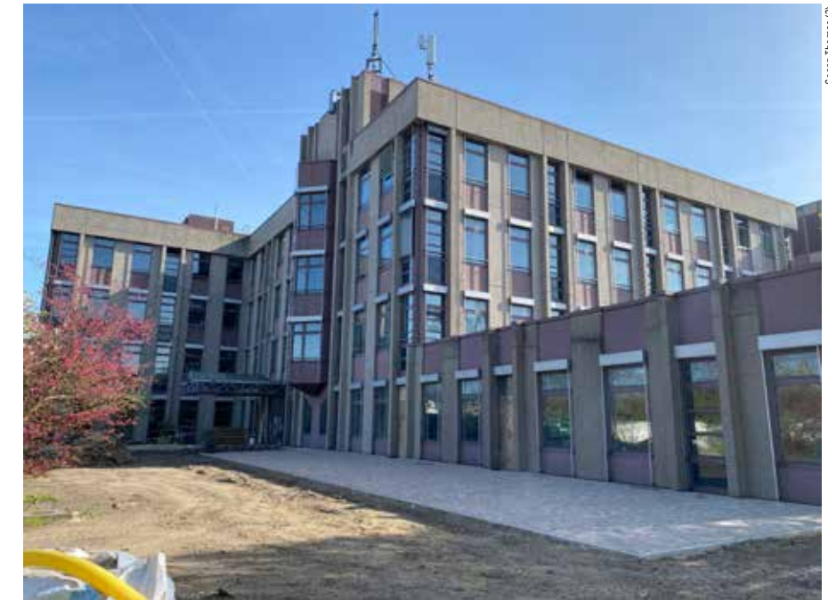
Der Anblick täuscht noch: Bald wird das Brainhouse247 in Laatzen auch von außen durch begrünte Fassaden im neuen Glanz erstrahlen. Im Innern ist jetzt schon alles neu und bereit für New Work.
