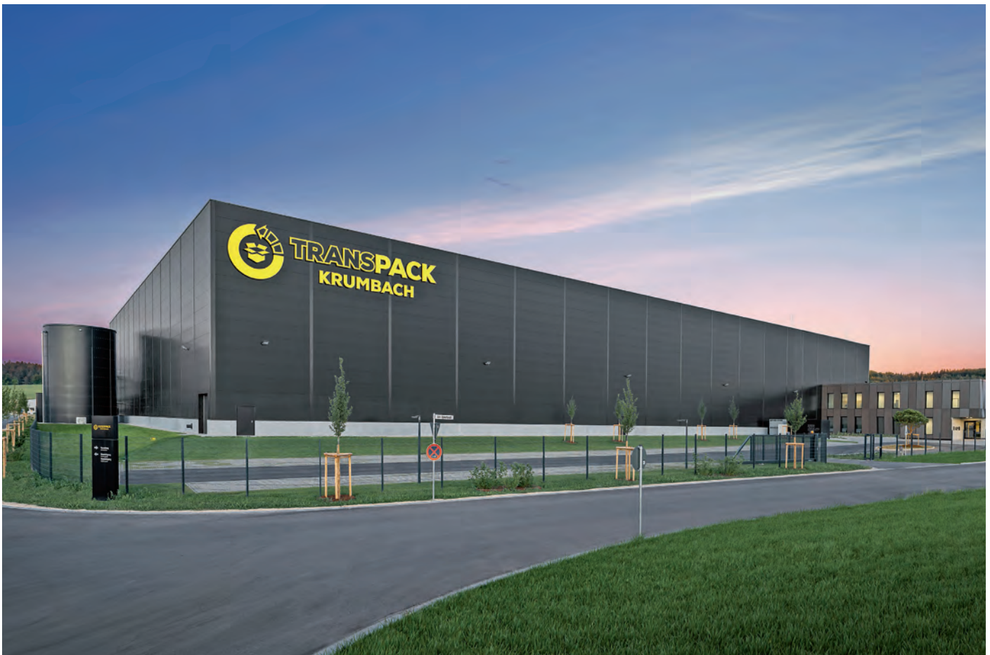
Nachhaltigkeit ist ein wichtiger Aspekt am neuen Betriebsgelände von TransPack-Krumbach in Neuburg an der Kammel. Foto: Andreas Jekic
