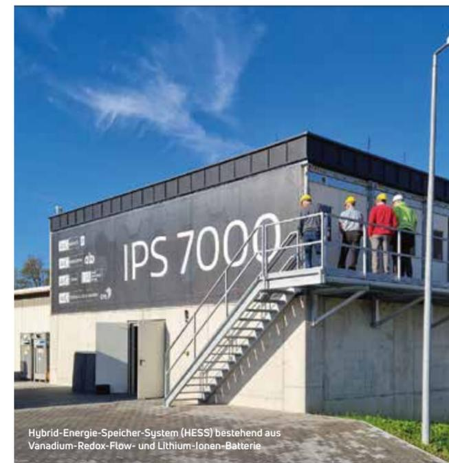
Hybrid-Energie-Speicher-System (HESS) bestehend aus Vanadium-Redox-Flow- und Lithium-Ionen-Batterie
