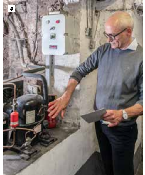
1. – 4. Was haben wir denn da? Rainer van Loon [Foto 1, hinten], Energieexperte der IHK Köln, findet Energiefresser auf einen Blick: Im „Palanta“ fällt ihm direkt auf, dass man Abwärme nutzen könnte, um beispielsweise Brauchwasser zu erwärmen. 5. Ein weiterer Kostenreduzierer: Kühlzellen und -theke miteinander verbinden, um noch stromeffizienter zu arbeiten.
