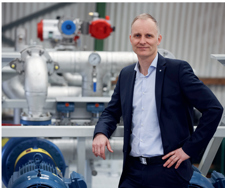
Vorfertigung in Merseburg: Geschäftsführer Frank Rüberg vor einem Skit, bestehend aus Pumpen, Armaturen und Rohrleitungen, das bei Weber entstanden ist.
