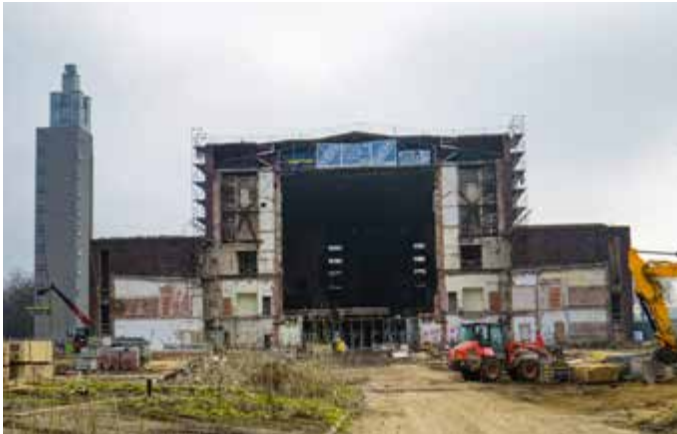
Die Stadthalle Magdeburg im aktuellen Bauzustand
