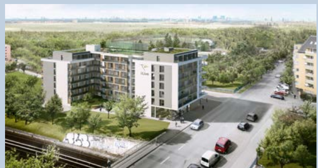
i Live Urban Living Tempelhof (Berlin) Gebäude. Foto: i Live Group GmbH
