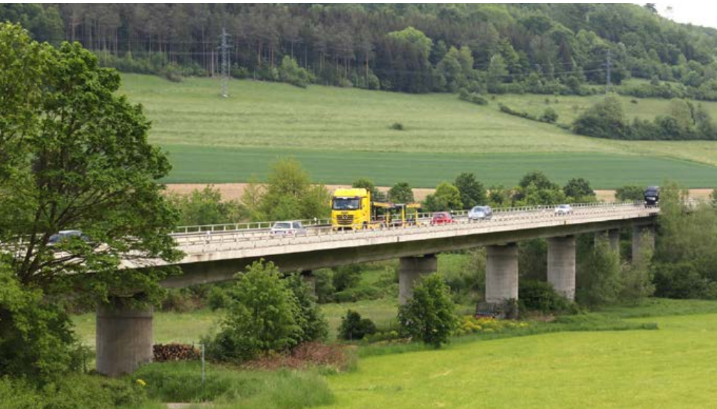
Kochertalbrücke in Unterkochen. Foto: IHK
