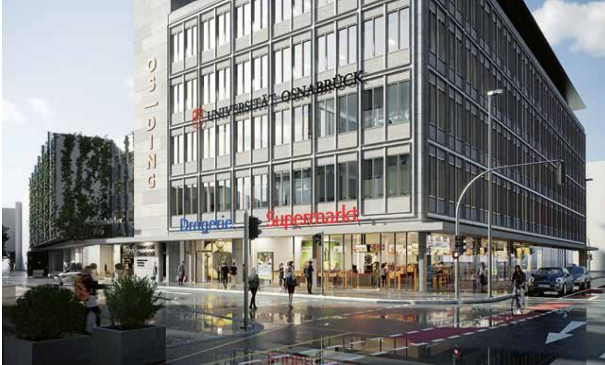
Das „Osnabrücker Ding“: Der Umbau der ehemaligen Immobilie von Galeria Kaufhof hat begonnen.
