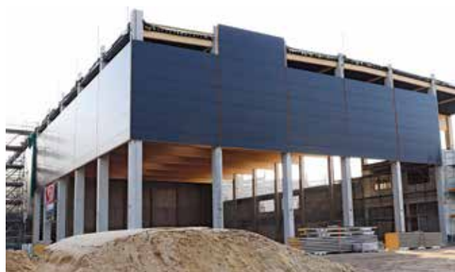
Neubau auf 7500 Quadratmetern: Die Einweihung soll im Herbst sein.
