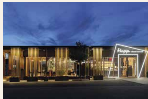
Bäckereifachgeschäft in modularer Holzbauweise in Bad Orb
