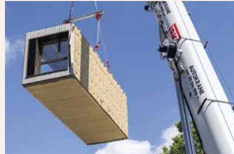
Raummodul in moderner Holzbauweise – komplett schlüsselfertig inkl. Fassadengestaltung
